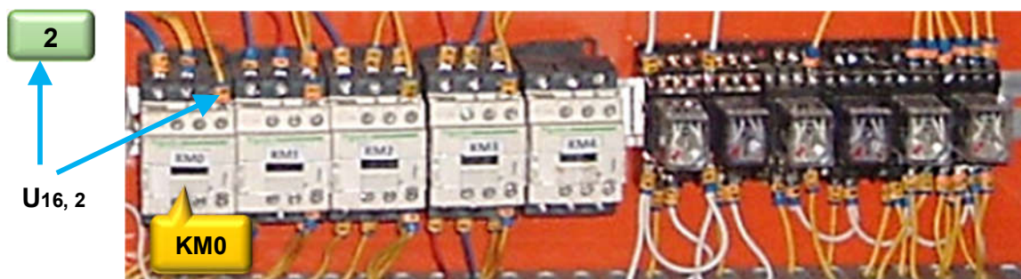
Hình 7.14: Đo điện áp 2 đầu công tắc tơ KM0
