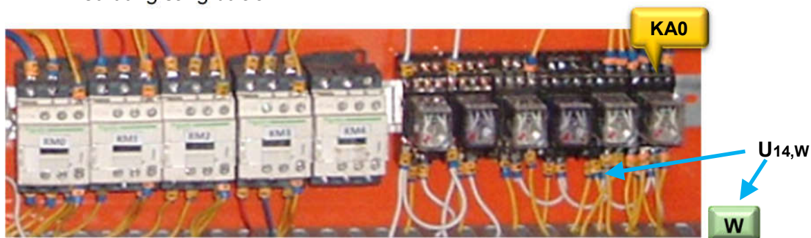
Hình 7.13: Đo điện áp 2 đầu rơ le KA0
